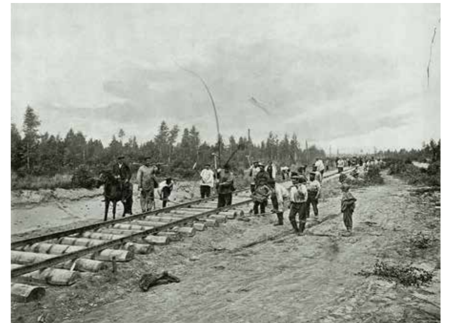
На строительстве Транссиба – самой длинной железнодорожной магистрали в мире (9288 км)
