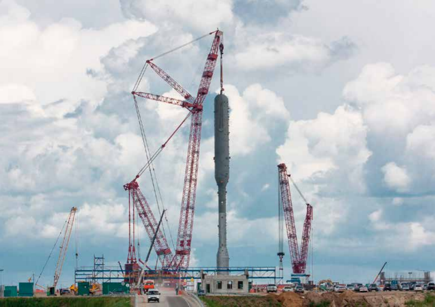
Монтаж крупнотоннажного оборудования на Амурском ГПЗ
