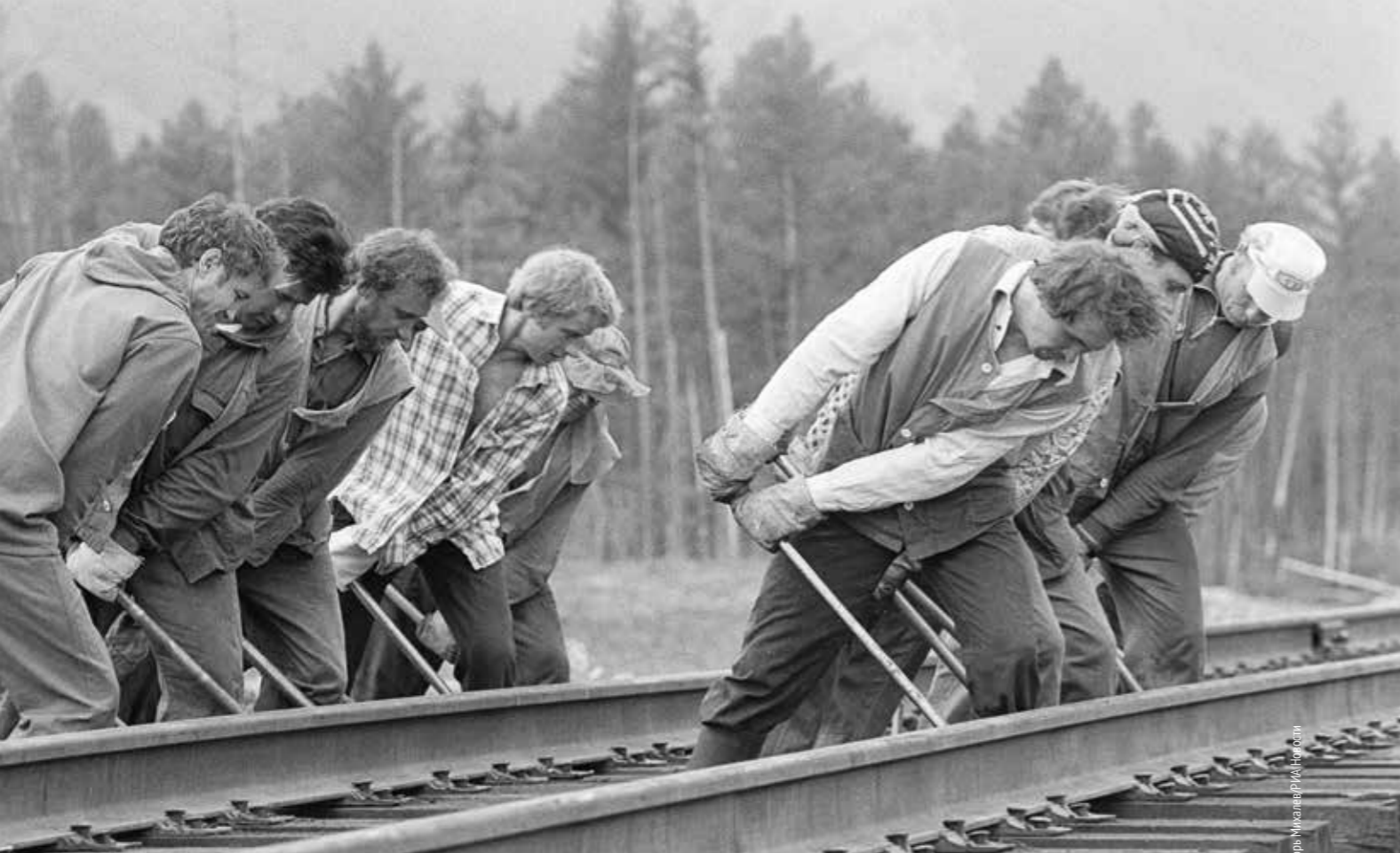
Укладка рельс на строительстве Байкало-Амурской магистрали
