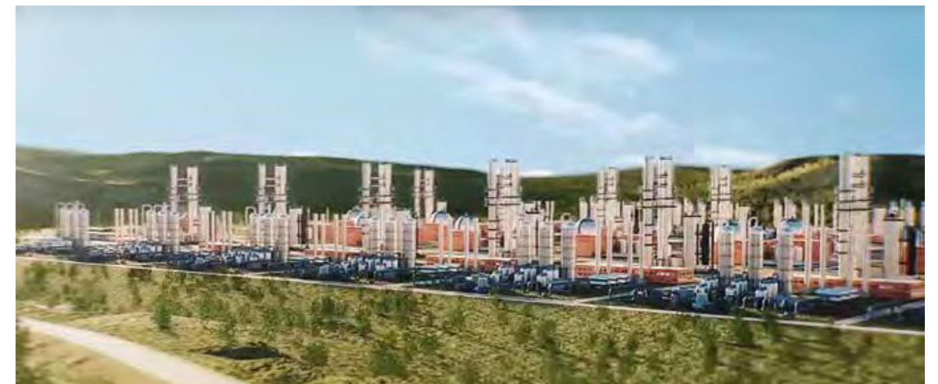
// В Амурской области началось строительство крупнейшего в России завода по переработке природного газа
